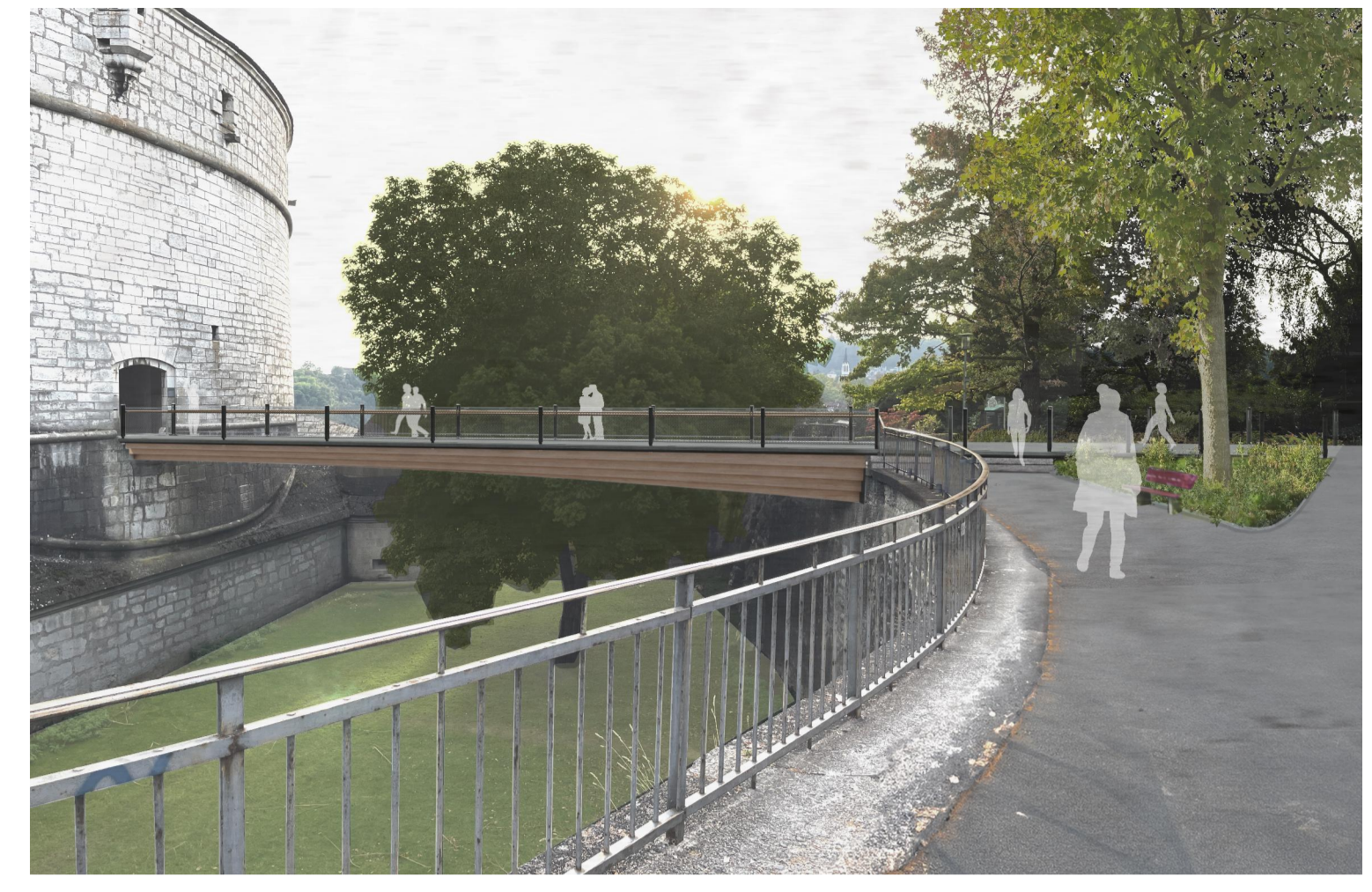
Blick nach Westen vor dem Auftritt auf den neuen Munotsteg
