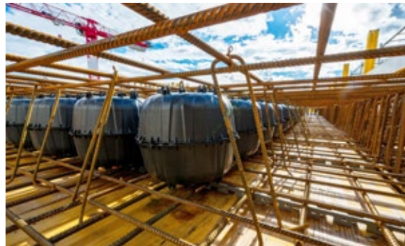
3 Zwischen den Bewehrungslagen verbaute Hohlkörper vor Einbringen des Betons
