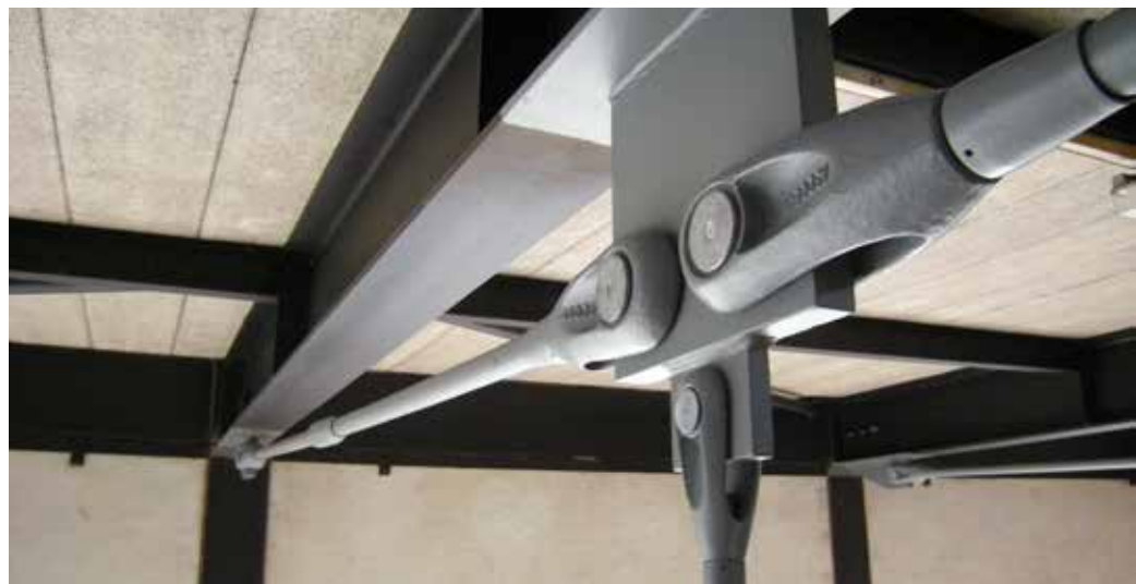
Unterspannung und Aufhängung eines Zwischenbodens (Werkhof Glattbrugg)
